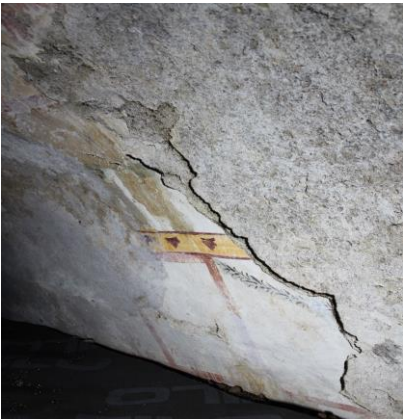
Lato Ovest – intonaco dipinto distaccato – prima e durante l'intervento
