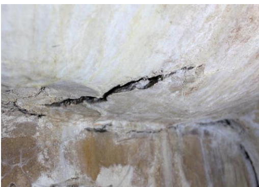
Bocca di lupo – lesione e distacco dell'intonaco prima e durante il consolidamento
