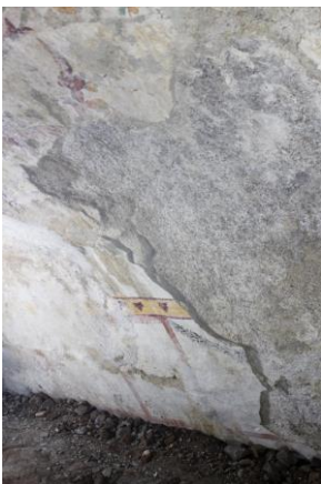
Particolare dopo il consolidamento e la sigillatura delle fessurazioni
